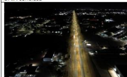
Foto 08: Iluminação do Eixo Principal do DAIA conclua
