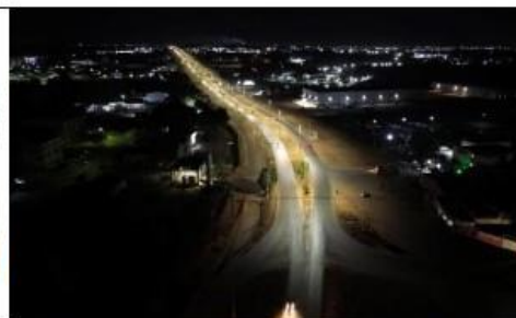
Foto 07: Iluminação do Eixo Principal do DAIA conclua
