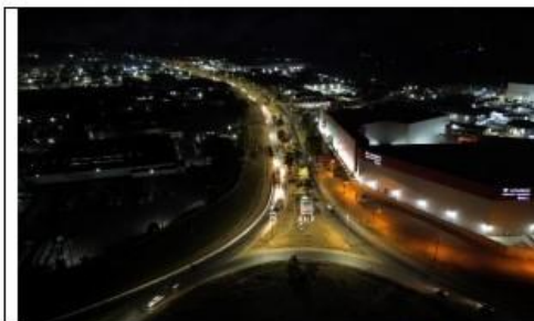
Foto 06: Iluminação do Eixo Principal do DAIA conclua
